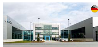
ARNOLD UMFORMTECHNIK Dörzbach Deutschland
