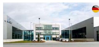
ARNOLD UMFORMTECHNIK Dörzbach Germany
