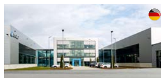
ARNOLD UMFORMTECHNIK Dörzbach Germany
